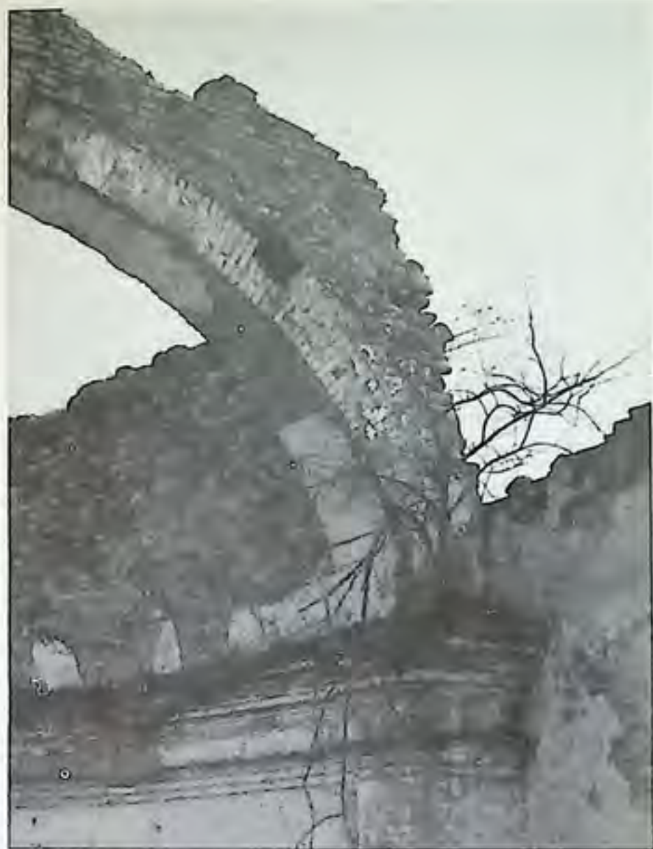
Particolare della Pieve vecchia (foto Simoni)
