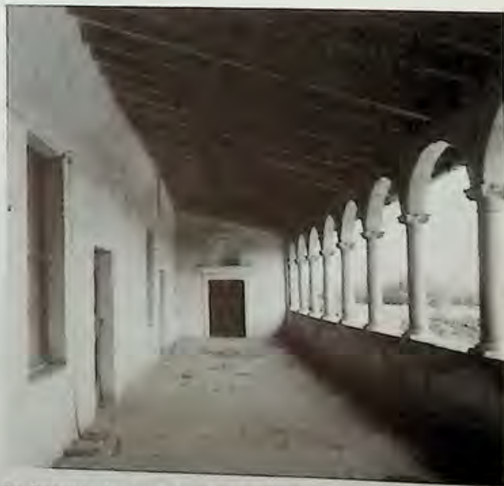
La loggetta al primo piano di "Casa Bornati"
